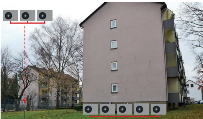
Insgesamt acht Wärmepumpen werden die 36 Wohnungen der Häuser Dornbachstraße 61 bis 65 mit Heizenergie versorgen.
