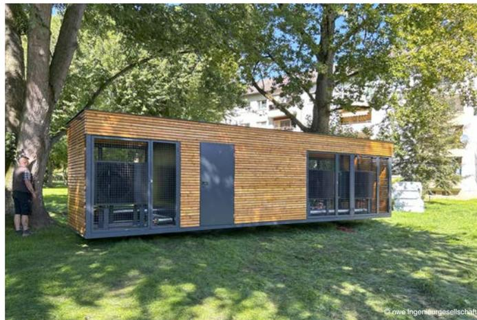
Ein „Energiecontainer“ dieser Art mit einer Wärmepumpe als Herzstück könnte künftig die Versorgung der Häuser Dornbachstraße 61 bis 65 mit Heizwärme und Warmwasser übernehmen.
