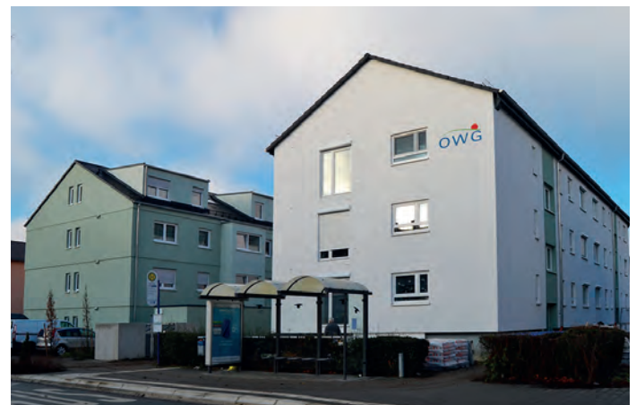
Die Häuser Bommersheimer Straße 62 bis 66 sind modernisiert. Bei Drucklegung dieser Ausgabe wurden die Balkone montiert.
