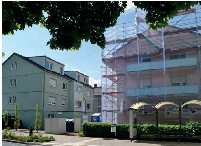
Die Häuser neben dem Neubau werden saniert.
